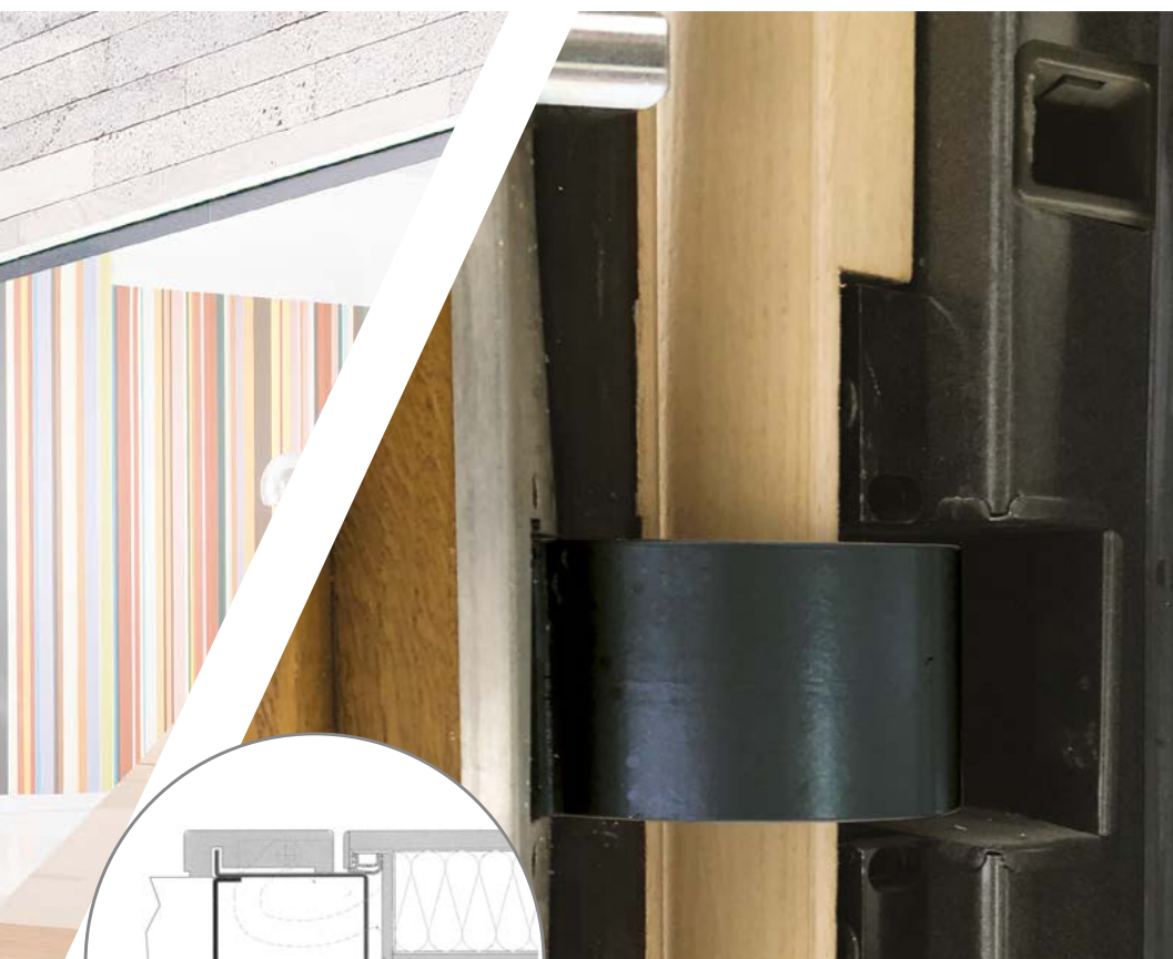
Dettaglio cerniera a scomparsa Hidden hinges detail
