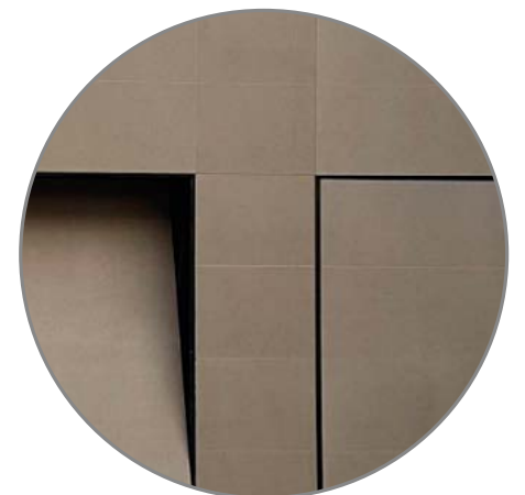
Particolare porta filo muro Détail porte affleurante
