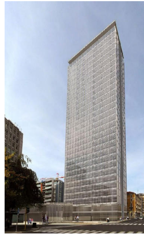
Torre Galfa a Milano
