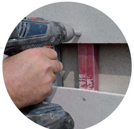
Installazione a controsoffitto con struttura doppia
