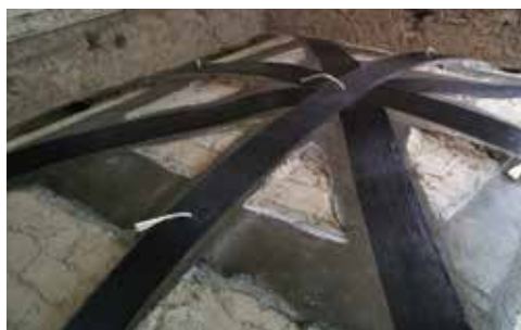
Rinforzo con FRP di volte in muratura
