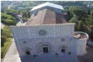
Rinforzo paramenti faccia a vista con cuciture e stilature armate STEEL ANCHORFIX e sistemi a reticolo con barre elicoidali ANCHORSTEEL NET
