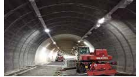
Consolidamento gallerie autostradali lesionate con STEEL NET G
