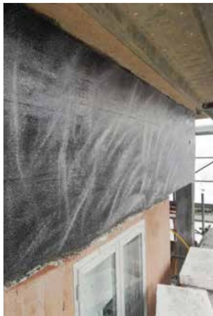
Rinforzo con FRP per nodi esterni e fasce di piano per c.a.
