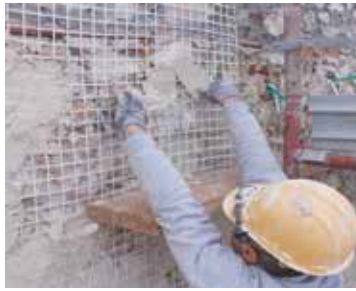
Rinforzo murature con sistemi FRCM e connettori a fiocco
