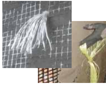
Rinforzo murature con sistemi FRCM e connettori a fiocco
