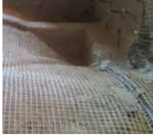
Rinforzo di volte con sistema FRCM reti in carbonio, vetro AR, tessuti in acciaio
