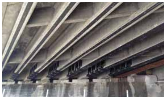
Rinforzo con FRP a flessione e taglio per travi da ponte in c.a. e c.a.p.
