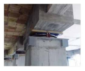
Figura 2: a. Realizzazione platea di fondazione e ringrosso pilatri e travi rovesce; b. isolatore in sommità al vano scale; c. isolatore in sommità al pilastro ringrossato
