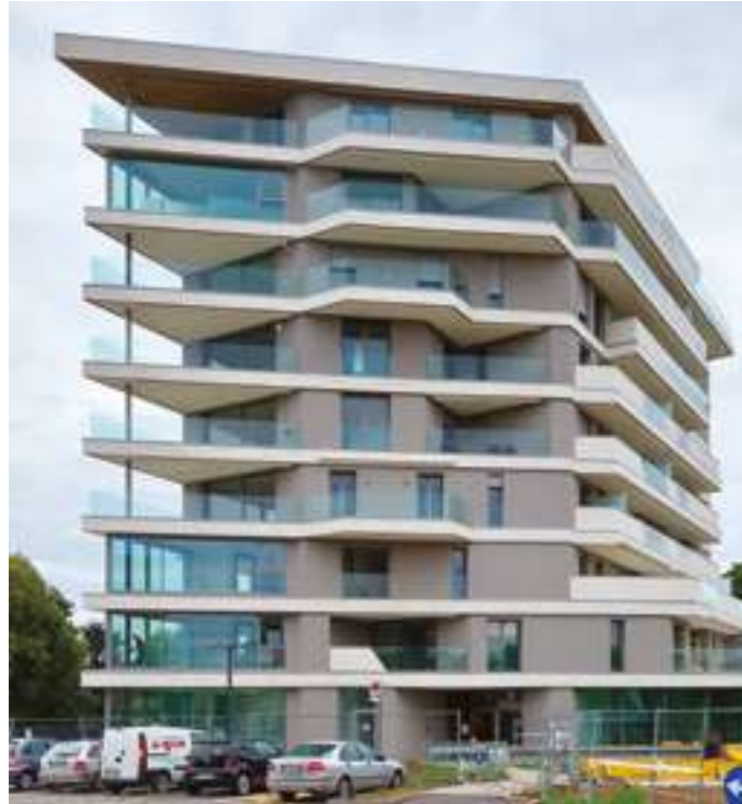
Residenza De Gasperi Partner: Vetreteria Bergamasca Tecnovetro Milano
