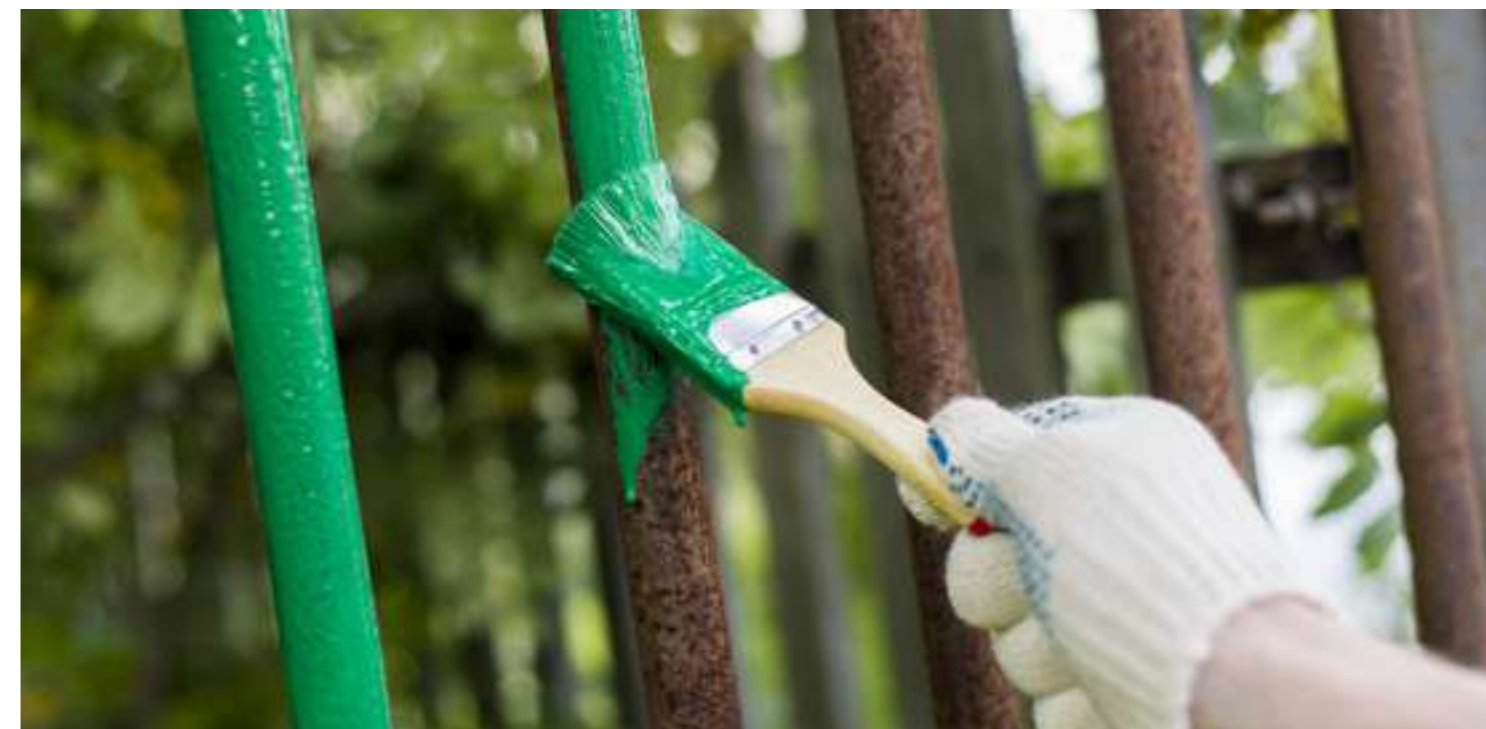
Manutenzione con trattamenti specifici antiruggine per i comuni parapetti in metallo, per evitare che gli stessi vengano corrosi dal tempo, perdendo bellezza e sicurezza.
