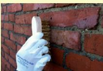
La preparazione della superficie consiste nel rimuovere tutte le sostanze che impediscano l'assorbimento del prodotto come muschio, alghe, polvere da smog etc, utilizzando eventualmente specifici detergenti alghicidi o disincrostanti.
