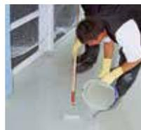
10 Lo strato di usura di Triflex ProTerra viene applicato sui dettagli e sulla superficie.
