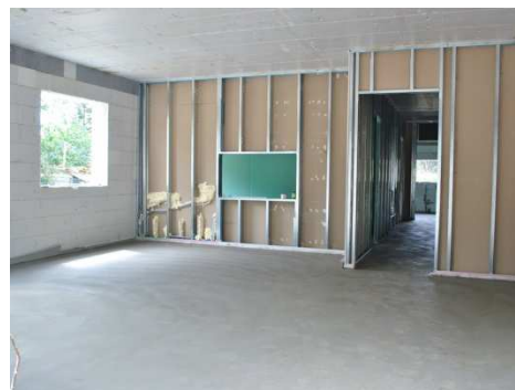
Pareti divisorie interne con struttura metallica
