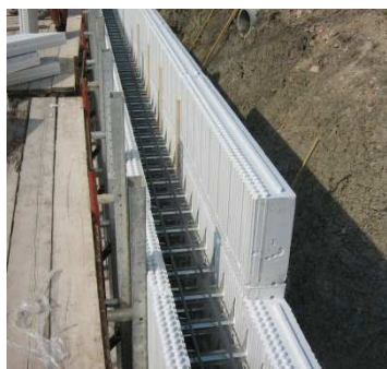
Posa della sponda solaio
