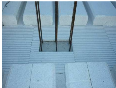
Taglio della lastra in corrispondenza del pilastro
