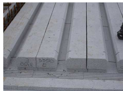
Accostamento dei pannelli
