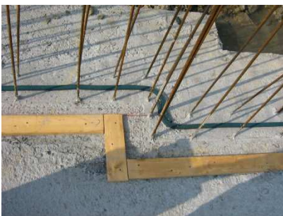
Posizionamento giunto bentonitico
