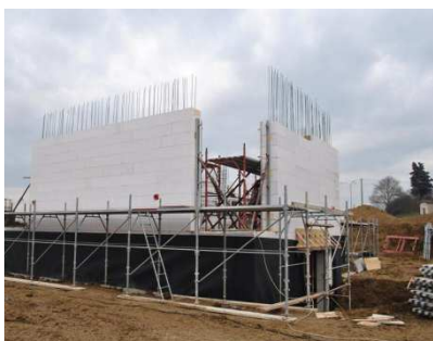
Vista dei ferri di ripresa
