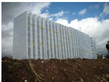
Scarico dei bancali in cantiere
