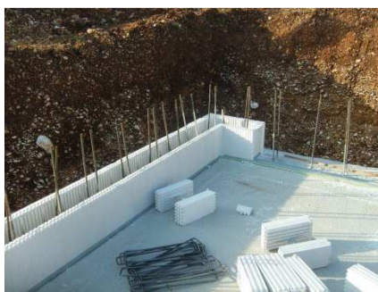
Accostamento dell' Elemento Base
