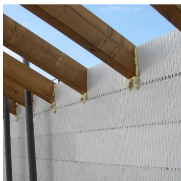
Tasche per alloggiamento travi
