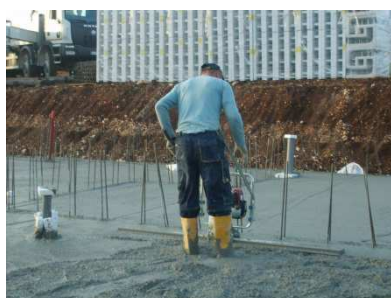
Livellamento del piano di posa al momento del getto
