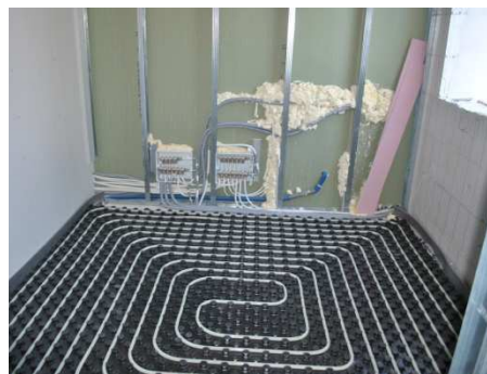
Controparete per installazione scatola di derivazione impianto riscaldamento
