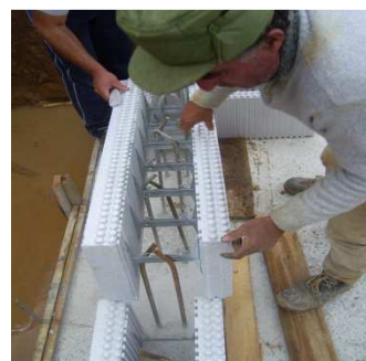
Posa del modulo tagliato a completamento del corso
