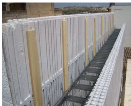
Fissaggio della sponda solaio con i Listelli Reggisponda
