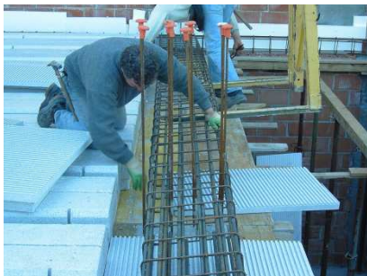
Posa della lastra sotto la trave a spessore
