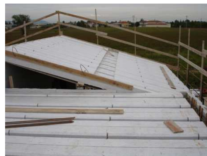
Correa su solaio di copertura
