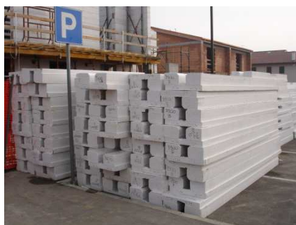
Stoccaggio pannelli in cantiere
