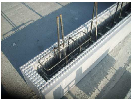
Posa delle staffette preassemblate all'interno del cassero
