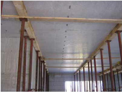
Banchinaggio solaio piano
