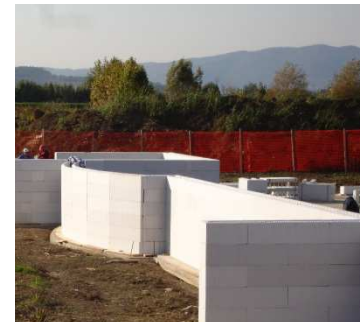
Vista esterna del muro circolare
