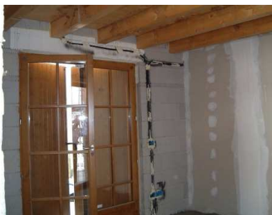
Tracce impianto elettrico
