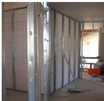
Posa delle lastre con struttura metallica
