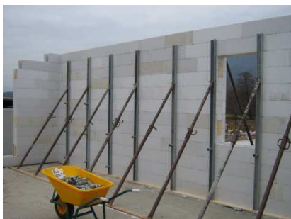
Paletti e tiraspingi all'interno della costruzione
