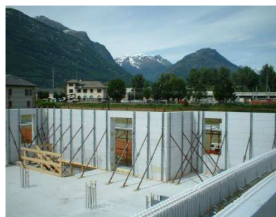
Vista interna del puntellamento
