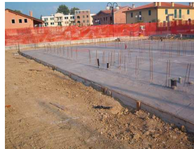
Soletta di completamento
