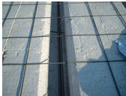
Posa delle armature per travetto
