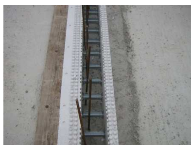
Correzione con aggiunta di malta nella porzione del cassero interno
