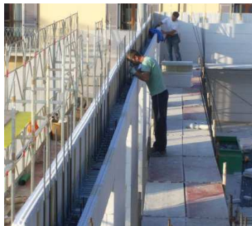
Verifica della disposizione dei ferri verticali
