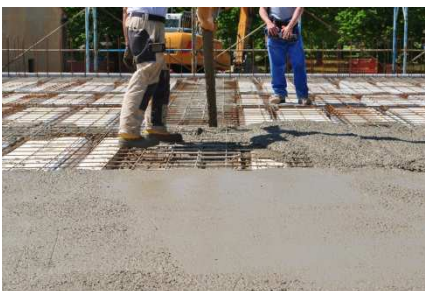
Getto del solaio
