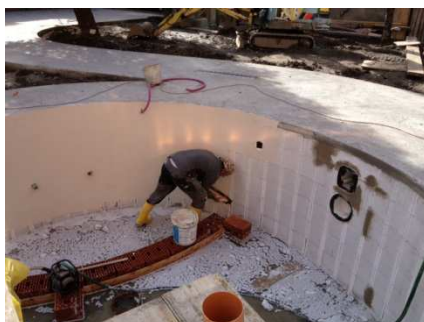
Impermeabilizzazione interna
