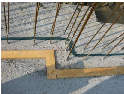
Disposizione giunto bentonitico al primo corso di elementi
