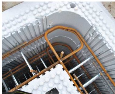
Particolare delle armature d'angolo
