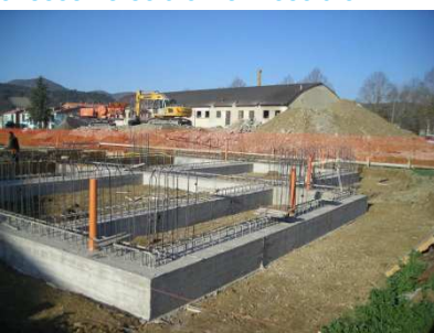
Getto delle travi di fondazione
