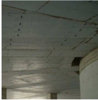
Foro adiacente la parete per passaggio canalizzazioni
