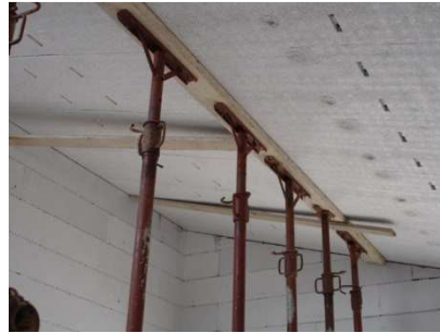
Banchinaggio solaio di copertura
