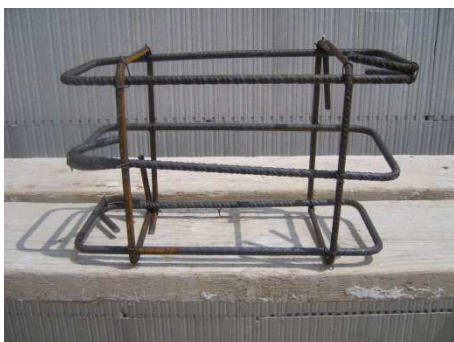
Staffe preassemblate di pass 10cm
