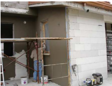
Prima rasatura della finitura "a cappotto"
