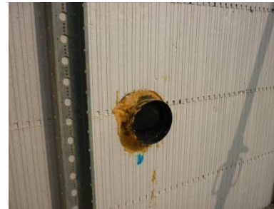
Predisposizione schiuma poliuretanica attorno al foro
