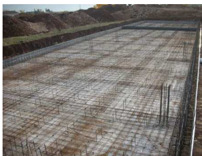
Armature della platea
