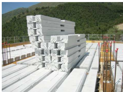
Stoccaggio dei pannelli al relativo piano di posa
