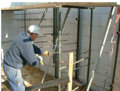
Predisposizione ferri di ripresa per scala
