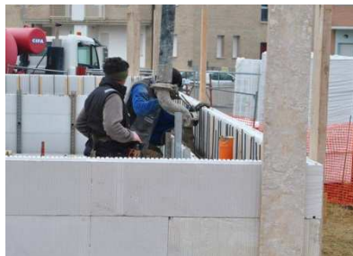
Getto della parete in prossimità dall'angolo
