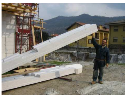
Movimentazione dei pannelli
