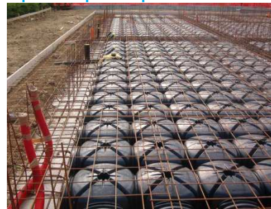
Disposizione delle cupole
