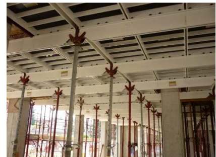
Sistema di puntellamento con casseraura modulare
