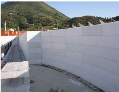
Vista interna del muro circolare a grande curvatura
