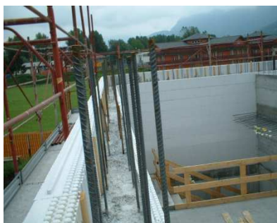
Ferri di ripresa uscenti dalla parete
