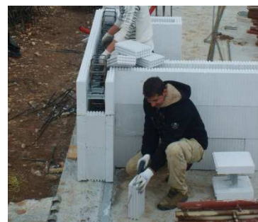
Taglio dell'Elemento di Chiusura in EPS
