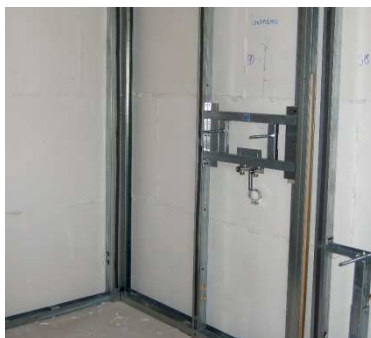
Rinforzi metallici su struttura per attacco cartongesso
