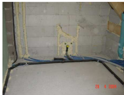
Chiusura tracce con schiuma poliuretanica
