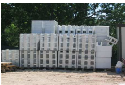
Stoccaggio del materiale all'esterno del perimetro dell'edificio
