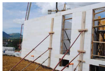
Puntellatura su spallette
