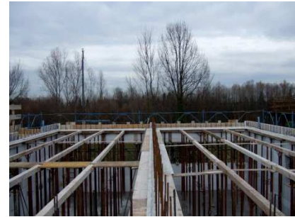
Vista dall'alto del banchinaggio
