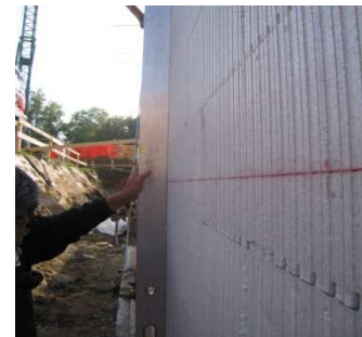
Verifica della verticalità
