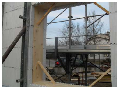
Predisposizione falso telaio
