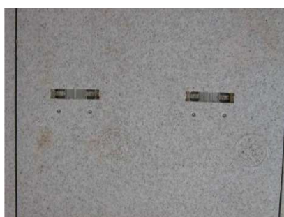
Vista delle asole per i profili metallici
