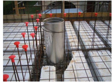
Foro per passaggio impianti o canne fumarie
