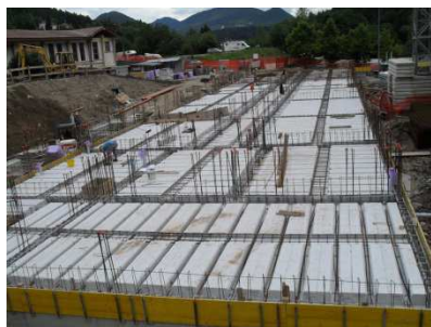
Getto del solaio di fondazione con pannelli-cassero Termosolaio
