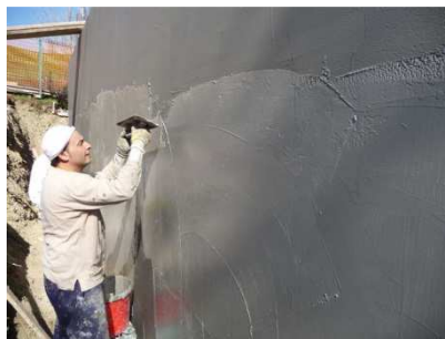
Impermeabilizzazione con soluzioni liquide stesa a spatola
