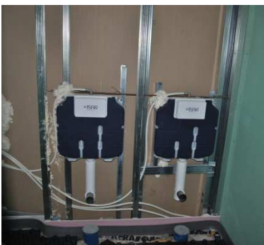
Controparete per installazione cassette per wc
