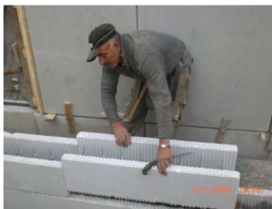
Posa Elemento Base al secondo corso
