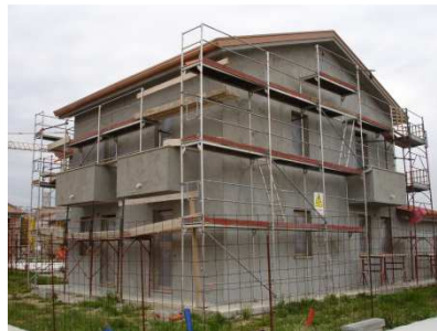
Rasatura completata. Superficie pronta per la tinteggiatura
