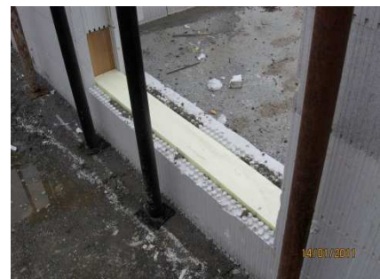
Isolamento con materassino della soglia di ingresso
