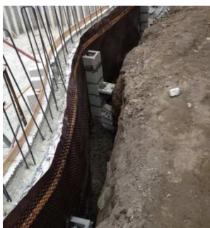
Impermeabilizzazione esterna della parete
