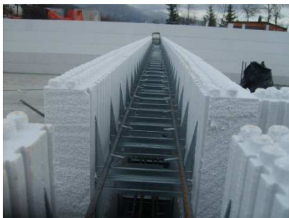
Alloggiamento delle barre orizzontali nel lamierino
