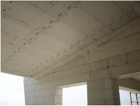
Taglio elementi Argisol in diagonale
