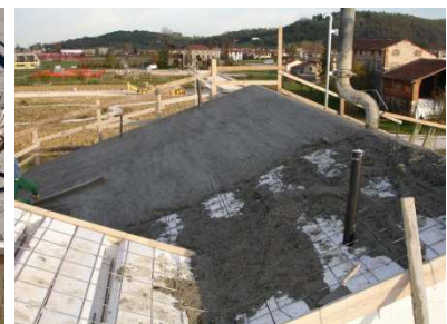
Getto su solaio inclinato
