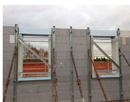
Posizionamento di serramenti di tipo monoblocco
