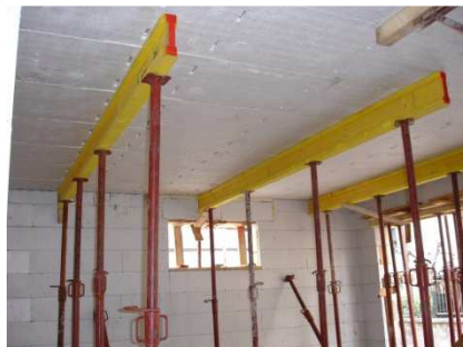
Puntelli e travi in legno ad "H"
