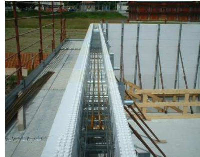
Integrazione armatura su architrave
