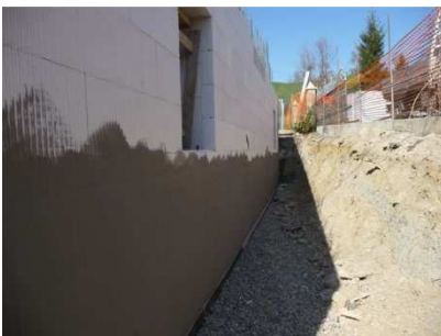
Preparazione della superficie con doppia rasatura e retina annegata
