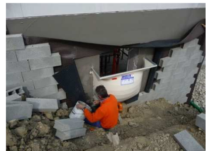
Rivestimento con guaina su parete rasata e successiva protezione
