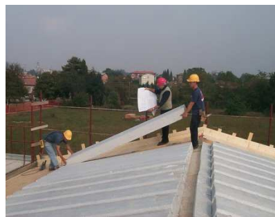
Posa dei pannelli come indicato nello schema di posa
