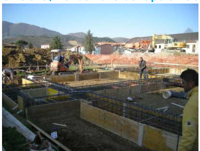
Casseratura delle travi di fondazione
