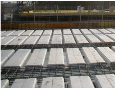
Posa delle armature delle travi
