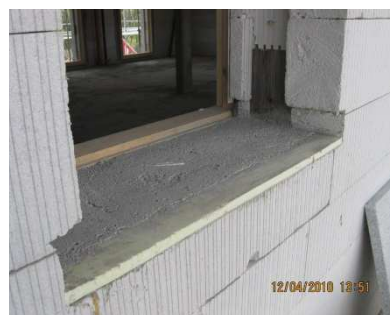
Sagomatura per alloggiamento del davanzale
