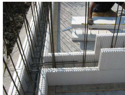
Inserimento dell'armatura orizzontale a posa ultimata del corso
