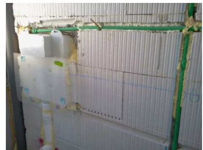
Cassetta inserita parzialmente nella parete
