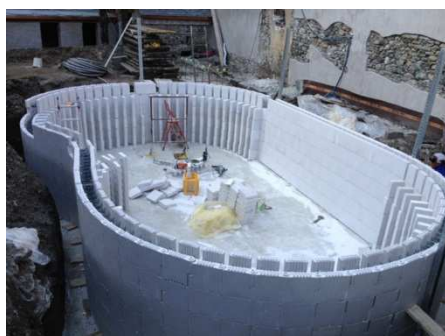
Ultimazione della posa ad altezza raggiunta
