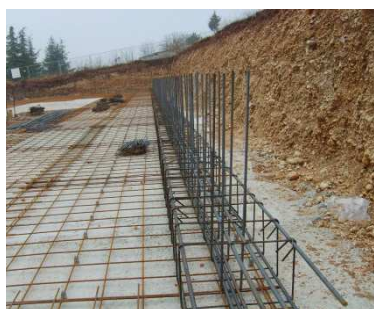
Predisposizione ferri di ripresa in fondazione
