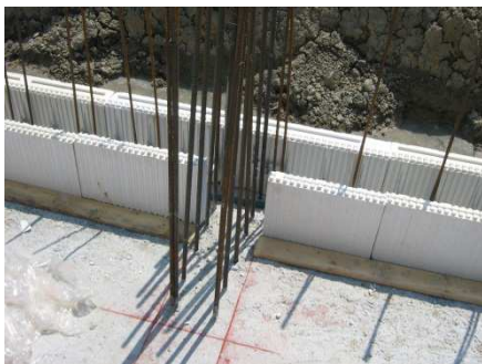
Taglio dell'Elemento Base in corrispondenza dell'incrocio
