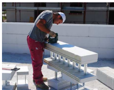
Taglio con seghetto elettrico
