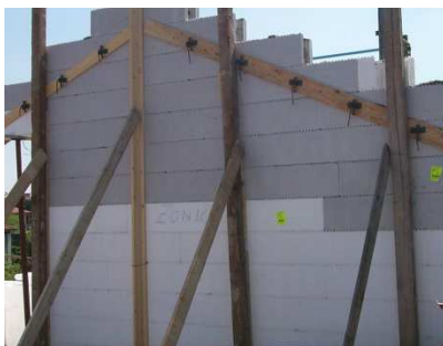
Predisposizione tavole per taglio diagonale dei moduli
