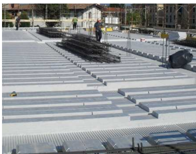
Particolare correa di ripartizione e predisposizione delle gabbie
