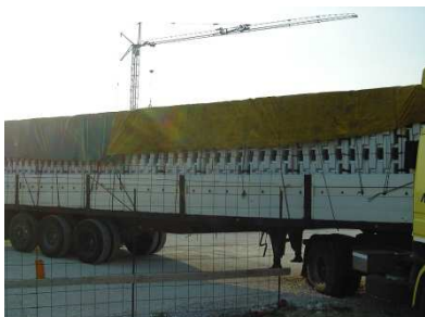
Arrivo franco cantiere con trasporto centinato
