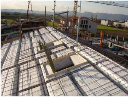
Velux su solaio di copertura
