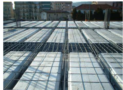
Posa della monconatura superiore e rete elettrosalsata
