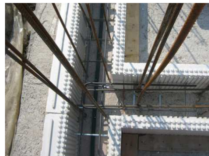
Particolare armature nelle intersezione a "T"
