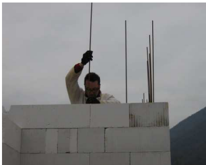
Posa dei ferri verticali
