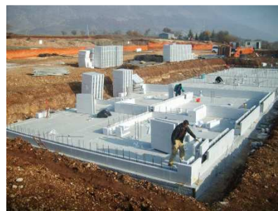
Posa del modulo parziale a chiusura del secondo corso
