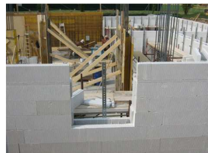
Vista del Variatore in facciata
