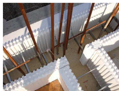
Inghisaggio di ferri d'angoli
