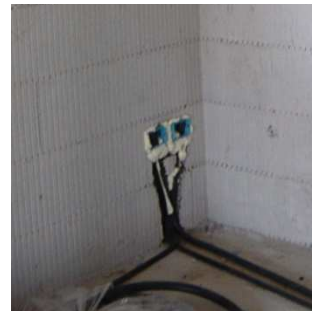
Scassi per scatole elettriche
