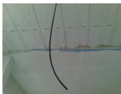
Finitura con intonaco previa rasatura con retina
