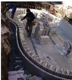
Posa dei vari moduli Raggio Variabile e Cunei
