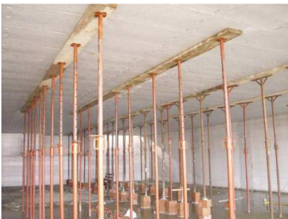
Banchinaggio tradizionale con puntelli e tavole in legno
