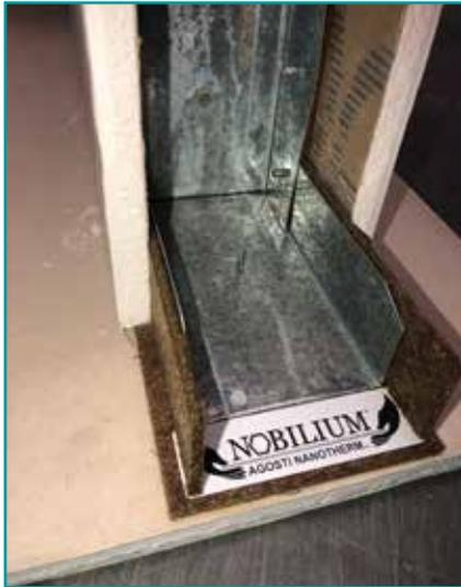
Isolation thermique et acoustique avec Nobilium® Thermalpanel de 3 mm pour les structures à « sec ».
