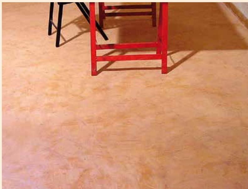
I rivestimenti continui ad alta resistenza della Linea **LIME COVER HT** sono ottenuti con malte preconfezionate in polvere, composte di calce idraulica naturale, inerti di carbonato, polveri di marmo e cocciopesto in opportuna curva granulometrica, terre naturali.
