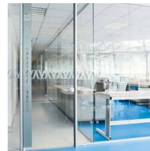
Pareti divisorie e porte integrate in vetro con profili in alluminio con sezioni minimali. Sede Laboratorio GENOMA / Roma. Work by Vetrouno.
