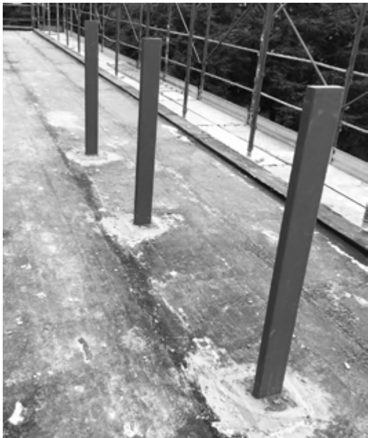
Immagine di cantiere prima dell'installazione di Giulietta
