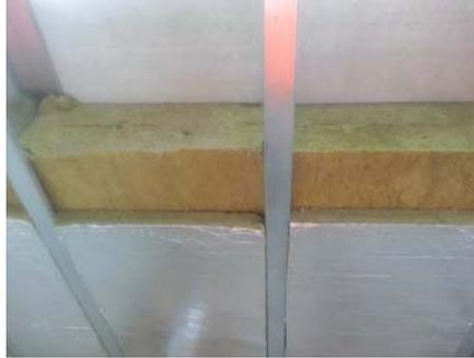
posizionati 250mm di lana di roccia ad alta densità 70 kg/mc con lamina di alluminio verso l'interno con funzione di barriera al vapore, doppia la-
