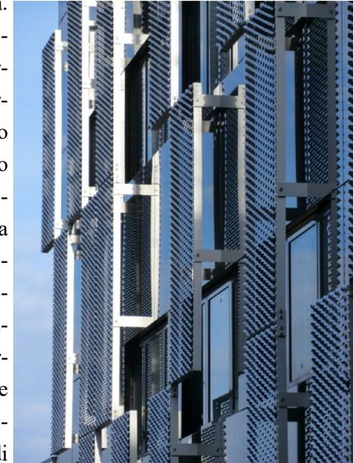
lastra Universal Rock® ed una facciata ventilata in alluminio appositamente progettata. La parete a secco ha un peso complessivo di 80,6 kg/mq, una trasmittanza lineare massima di 0,144 W/mqK, una trasmittanza periodica estiva di 0,041 W/mqK, un fattore di attenuazione estivo pari a 0,287 ed uno sfasamento di 9h e 37' con assenza di condensa interstiziale grazie all'impiego di barriera al vapore, valori a cui va aggiunto l'ulteriore apporto della facciata in alluminio.
