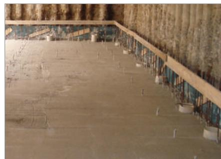
Particolari fotografici della sequenza completa di posa in opera: realizzazione dell'impalcato, posa di U-bahn Beton® e dell'armatura della struttura, getto e lisciatura finale.
