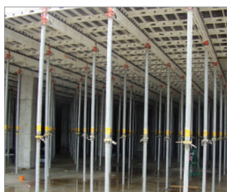
Particolari fotografici della sequenza completa di posa in opera: realizzazione dell'impalcato, posa di U-Boot Beton ® e dell'armatura della struttura, primo getto, getto di completamente con lisciatura finale.
