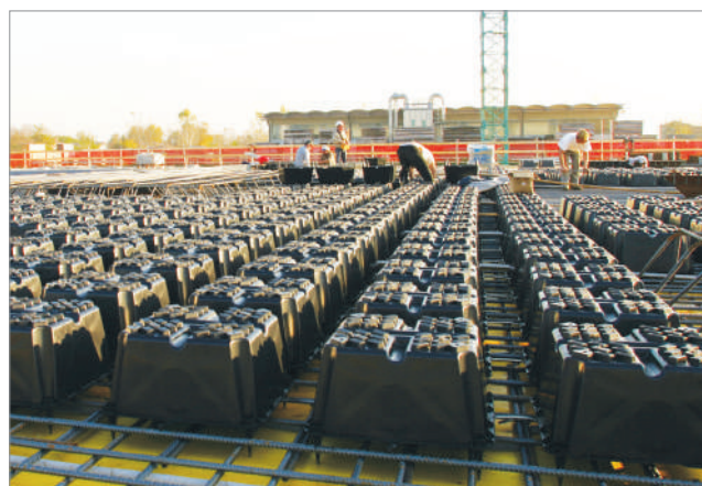
Edificio ad uso industriale
