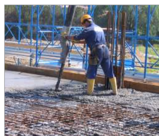
Particolari fotografici della sequenza completa di posa in opera: realizzazione dell'impalcato, posa di U-Boot Beton ® e dell'armatura della struttura, primo getto, getto di completamente con lisciatura finale.
