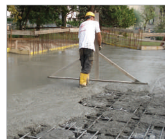
Particolari fotografici della sequenza completa di posa in opera: realizzazione dell'impalcato, posa di U-Boot Beton ® e dell'armatura della struttura, primo getto, getto di completamente con lisciatura finale.
