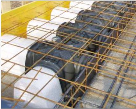
La **Prolunga** è un elemento in polistirolo espanso di idonea densità per resistere alla pressione del calcestruzzo che consente lo sviluppo di un solaio ventilato di qualsiasi forma e dimensione.
