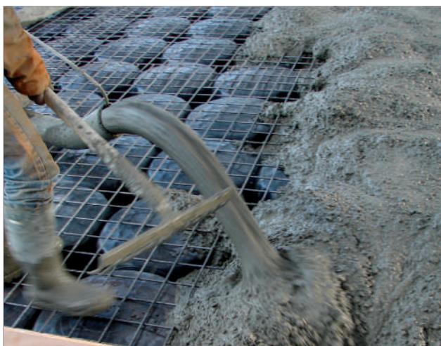
Le casseforme modulari in plastica Iglu®, affiancate in sequenza secondo un senso prestabilito, consentono la rapida formazione di una piattaforma pedonale autoportante sopra la quale viene eseguita una gettata di calcestruzzo a costituire, in modo estremamente semplice ed economico, un solaio aerato poggiante su supporti verticali con l'area sottostante cava sfruttabile per il passaggio degli impianti ma soprattutto ventilata a contrasto dell'umidità di risalita e dei gas radioattivi.
