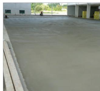
Particolari della sequenza completa di posa di Iglu<sup>®</sup>, successiva armatura, getto e lisciatura.
