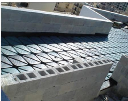
Un tema sempre più importante degli ultimi anni è l'eccessivo consumo energetico degli edifici, consumo che è possibile ridurre in modo considerevole attraverso un'intelligente variante di impiego dell'Iglu®: la ventilazione del tetto. Posizionando sulla copertura orizzontale dell'edificio i casseri Iglu® si viene a creare un'intercapedine d'aria che permette di isolare dal caldo in estate e dal freddo in inverno, con conseguente risparmio nella climatizzazione degli ambienti interni.
