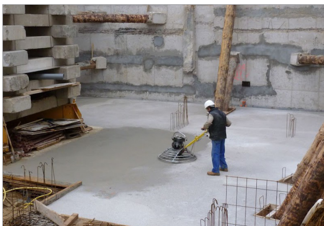
Getto e successiva lisciatura del calcestruzzo
