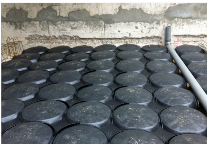
Posa dei casseri Coffrargile e dell'accessorio Beton Up
