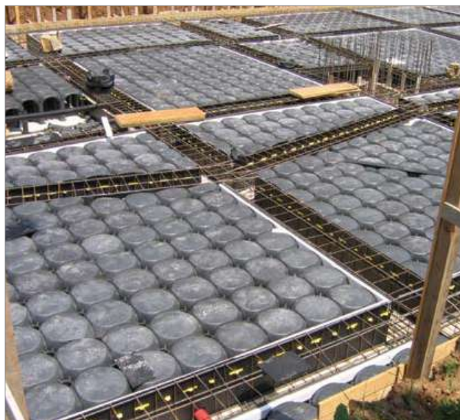
Atlantis System i kombination med Muro formsättning
