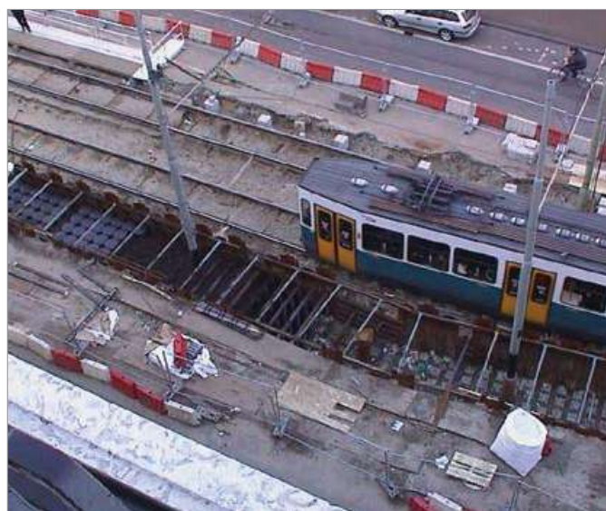
Renovering av en tågplattform
