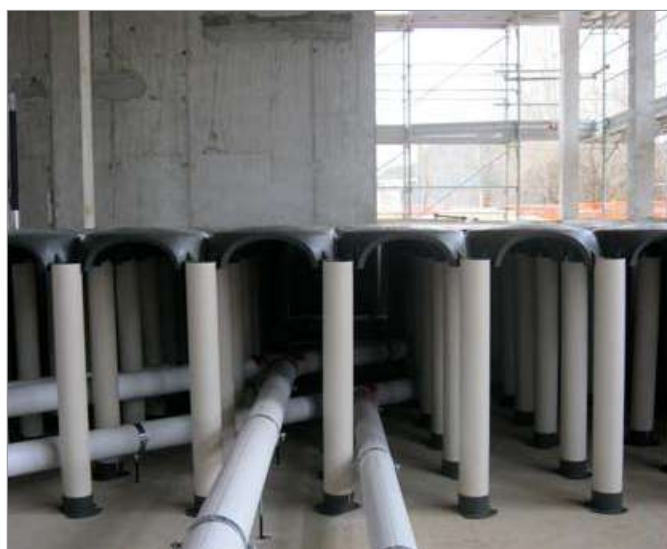
Проводка инженерных сетей под полом в любых направлениях
