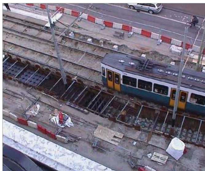
Reconstrução da plataforma do metropolitano
