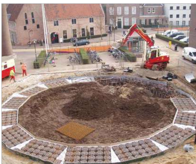
Proteção das raízes das árvores (Waterblock Holanda)
