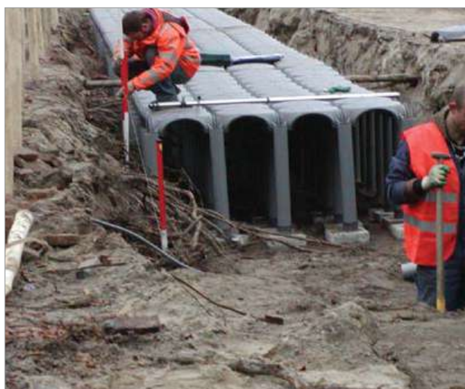
Câmara com função salva raízes
