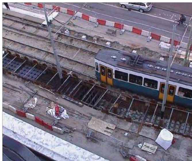
Restauro banchina della metropolitana
