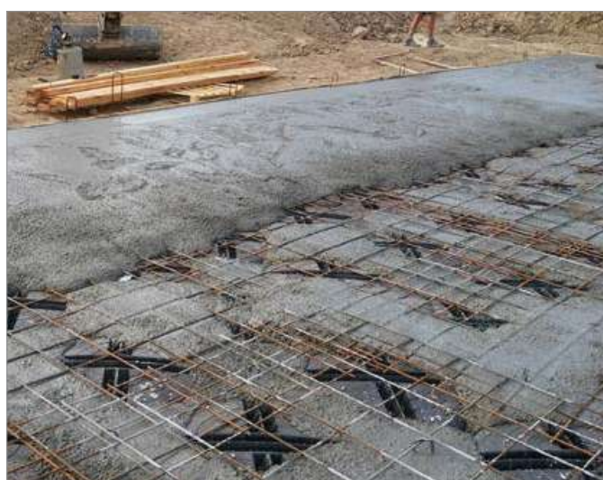
Edificio a uso residenziale
