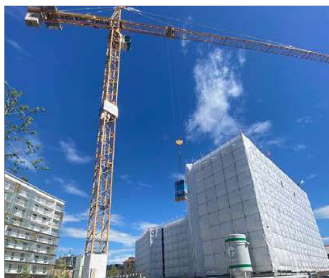
Facile movimentazione in cantiere
