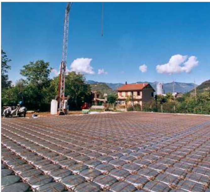
Edificio a uso residenziale
