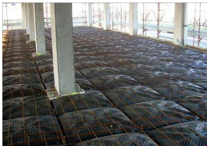
Edificio a uso residenziale
