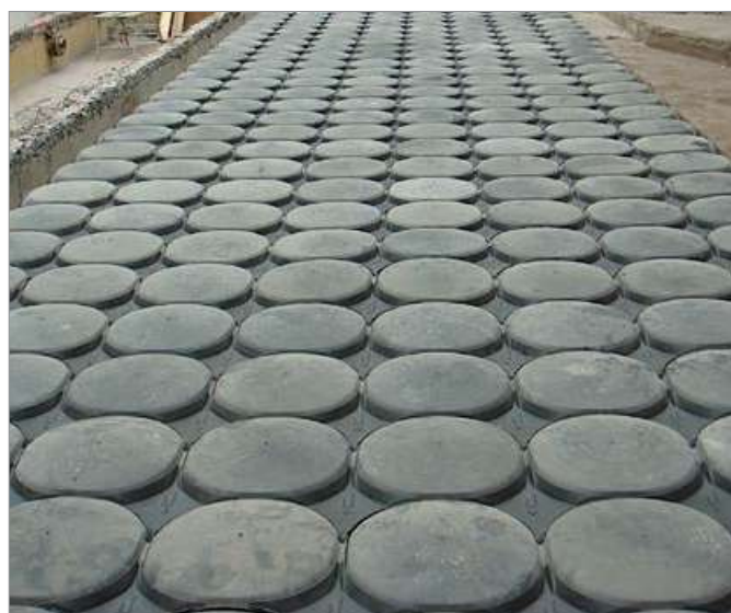
Système Atlantis et Beton Up - Dalle monolithique liée au contour
