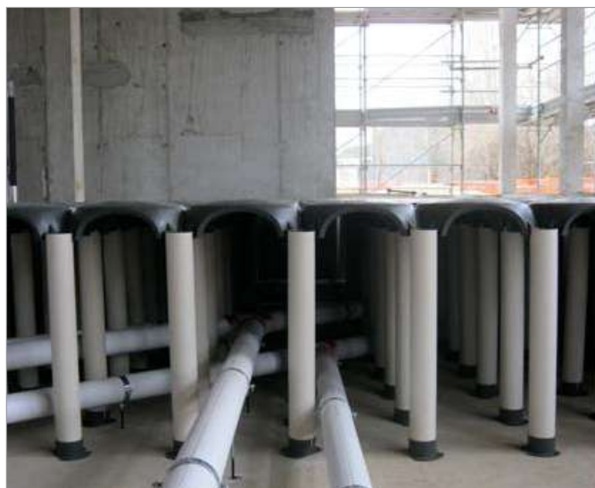
Paso de las instalaciones
