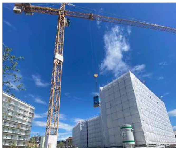
Agile Handhabung auf der Baustelle
