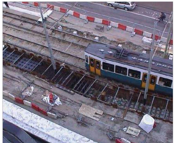
Instandsetzung des Bahnsteigs der U-Bahn
