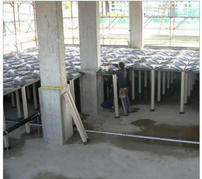
Belüftungshohlraum für Industriegebäude
