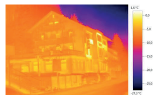
Immagine termica senza testo ScaleAssist
