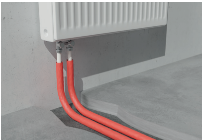
Fig. 43: Collegamento diretto dei tubi Tigris MP mediante adattatori in ottone "Eurocono" (solitamente a corredo delle valvole).
