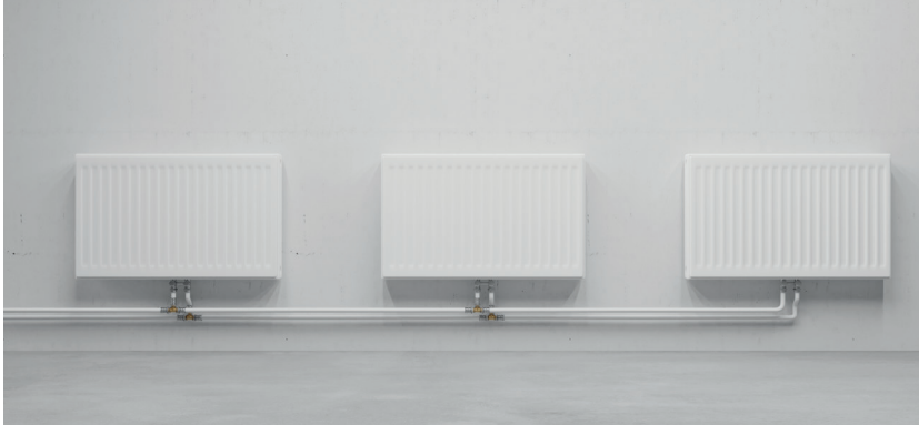
Fig. 42: Sistema di distribuzione a due tubi (standard).
