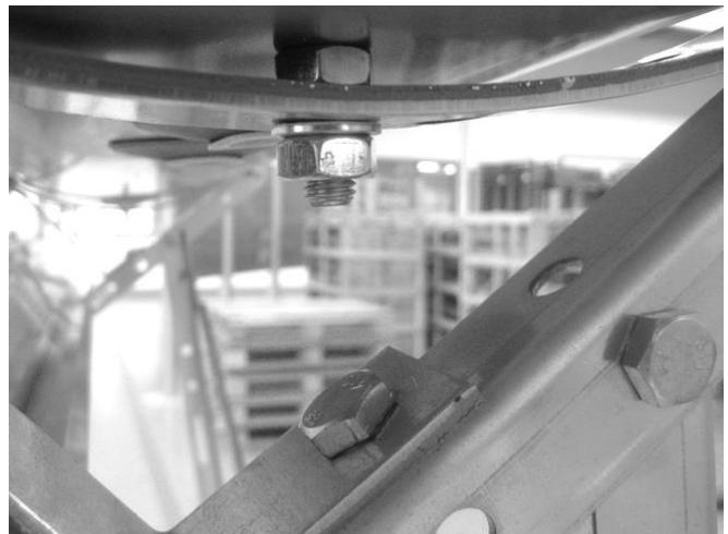
4.2 Fissare i due tappi a stringere Ø22 mm sulle connessioni in alto a sinistra e in basso a destra del collettore solare.
