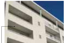
Condomini Logement collectif Collective housing
