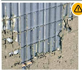
Il controtelaio è una struttura metallica che, integrata a materiali inerti, va a formare un'unica parete. Poiché tale struttura è soggetta a vibrazioni, per evitare l'insorgere di fessurazioni/deformazioni, la preparazione dell'intonaco deve essere eseguita a regola d'arte rispettando scrupolosamente tutte le seguenti istruzioni:
