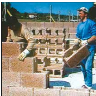
Successivamente tutti gli altri corsi si posano a secco.
