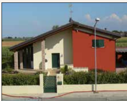
Intervento a Sant'Agostino (FE)
