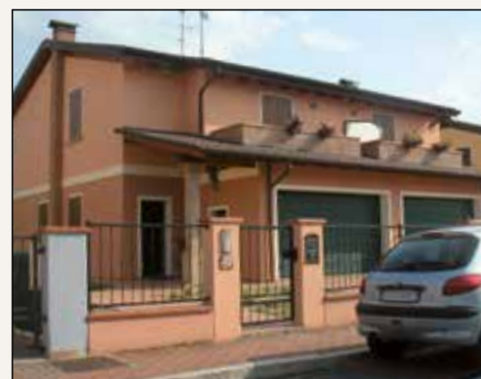
Intervento a Concordia (MO)
