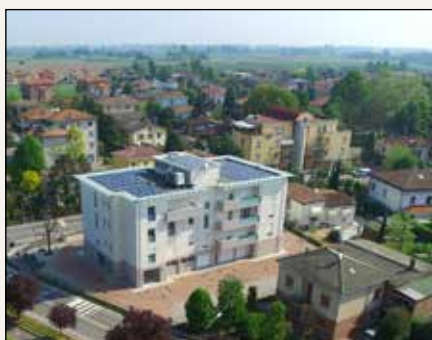
Intervento a Cavezzo (MO)
