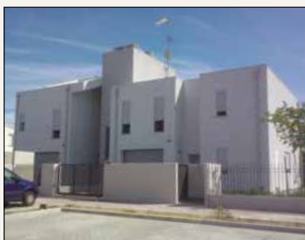
Intervento a Carpi (MO)
