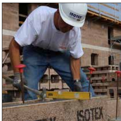
Nella fondazione vengono inseriti i ferri di chiamata.
