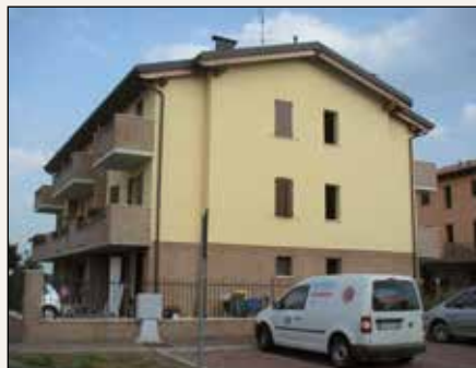
Intervento a Novi (MO)
