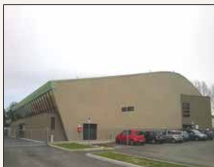
Intervento a Novi (MO)
