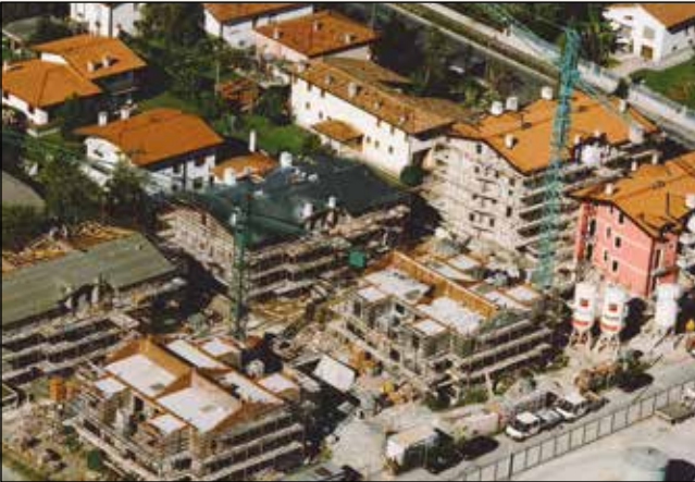
Intervento di 52 abitazioni a Cervignano (UD)
