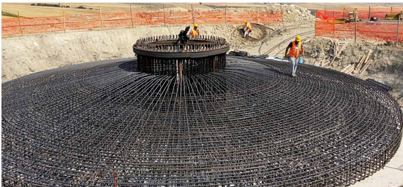
Piattaforma di sostegno di pala eolica. Ancoraggio in profondità della piattaforma facilmente eseguibile con TRACK PILE®.
