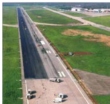
Una veduta aerea dei lavori di fresatura e consolidamento
