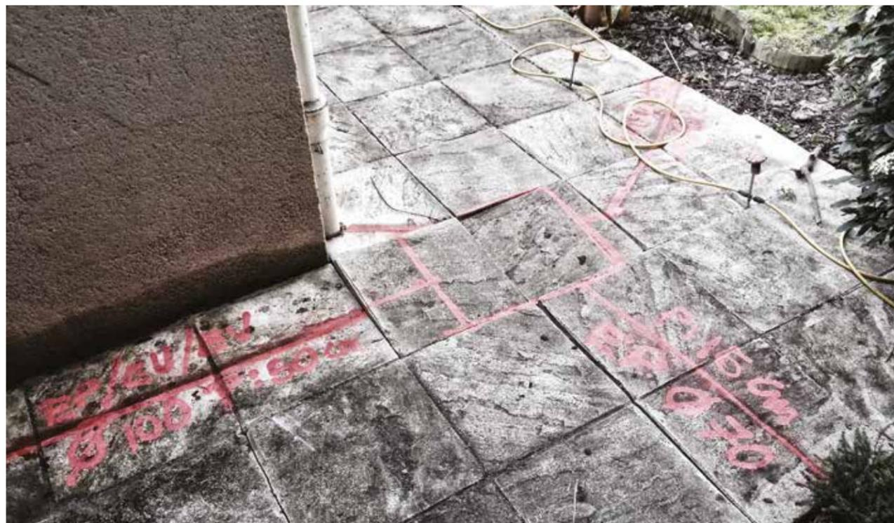
Prima di procedere all'esecuzione dei fori nel pavimento per la successiva posa dei tubi di iniezione, diventa importante poter identificare il posizionamento di impianti, tubazioni e strutture generalmente interferenti con le iniezioni. La ricerca di queste informazioni potrà avvenire attraverso la documentazione storica di progetto della costruzione qualora nelle disponibilità del cliente, ma soprattutto con maggior sicurezza mediante prove strumentali non distruttive
