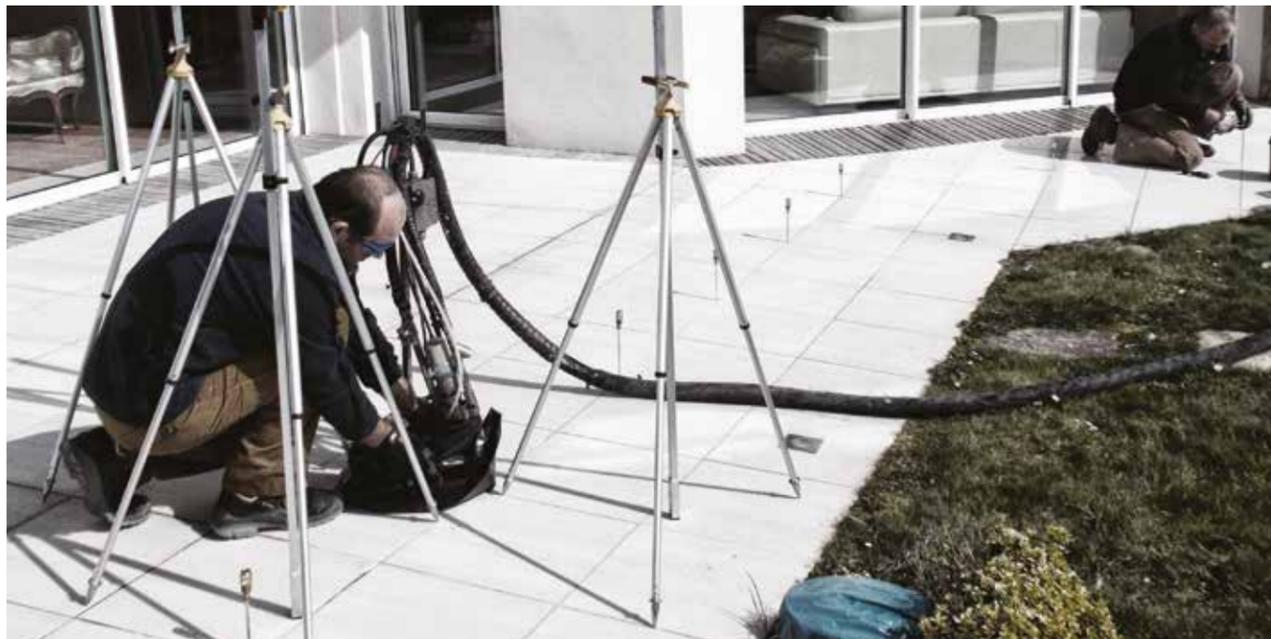
Realizzati i piccoli fori, potranno essere infilati dei tubicini in metallo a perdere nel sottofondo per la successiva immissione della resina. In sommità al tubo verrà fissato un raccordo ad attacco rapido, per accogliere il terminale di iniezione che giungerà dal camion-officina. Collegato il terminale al tubo, gli operatori posizioneranno la strumentazione di controllo laser dei sollevamenti in prossimità del punto stesso di iniezione, per monitorare
