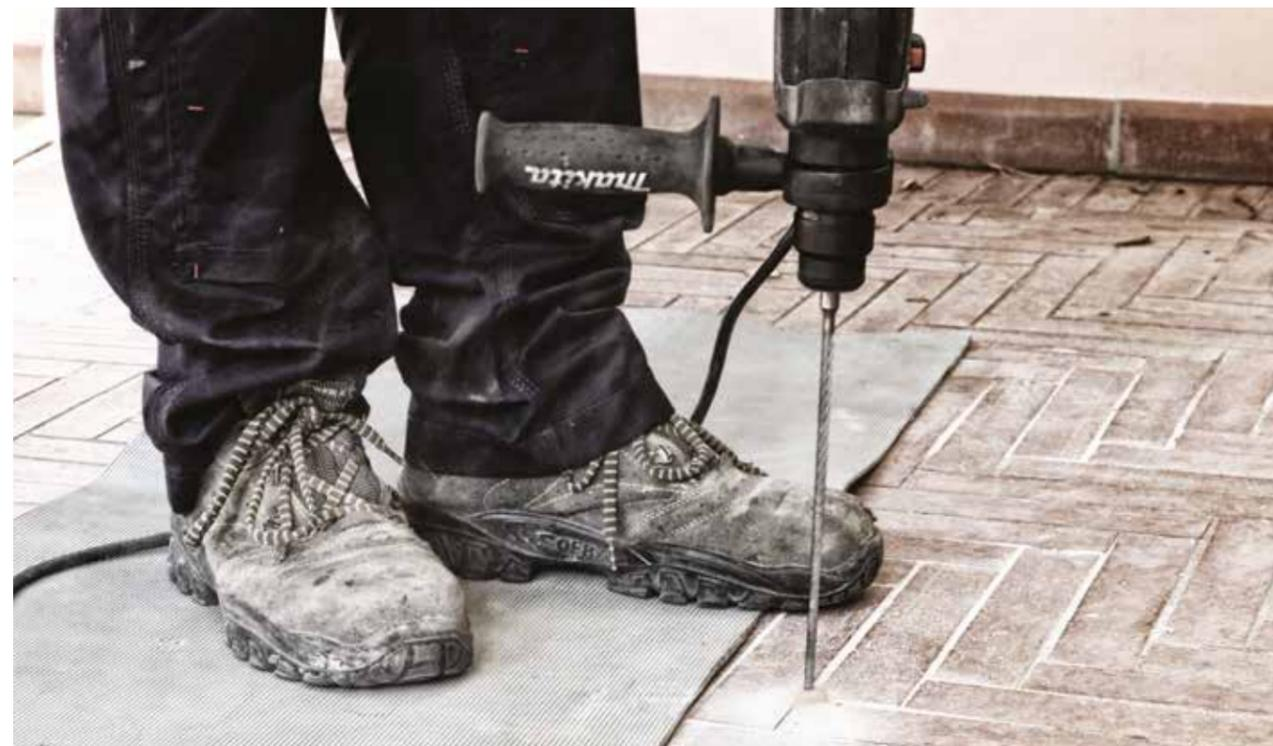
Definite le aree d'intervento e dunque depresse, segnalate le posizioni degli impianti e delle tubazioni interferenti, sarà possibile realizzare i piccoli fori di iniezione mediante trapani manuali e punte adeguate a perforare preferibilmente, quando possibile, proprio in luogo delle fughe del pavimento.
