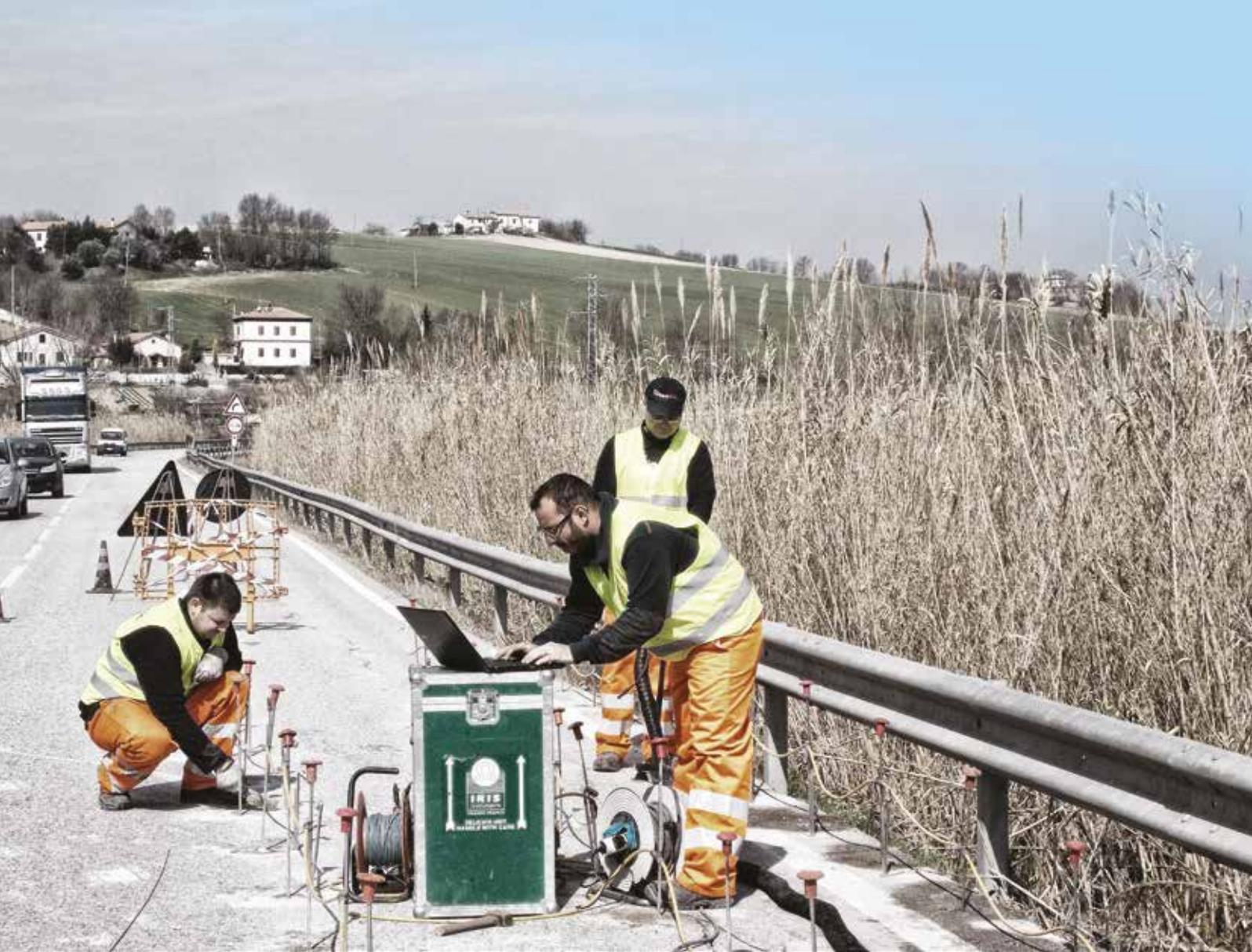
Durante il consolidamento, è garantito il **controllo costante** del principio di sollevamento della pavimentazione stradale mediante livelle laser e ricevitori di precisione millimetrica. La **profondità d'iniezione** oltre lo strato di sottofondo, soprattutto in presenza di carichi di esercizio molto elevati, potrà essere implementato con l'applicazione del metodo **SEE&SHOOT®** nelle modalità descritte nella sezione dedicata alle **iniezioni di resina espandente**.
