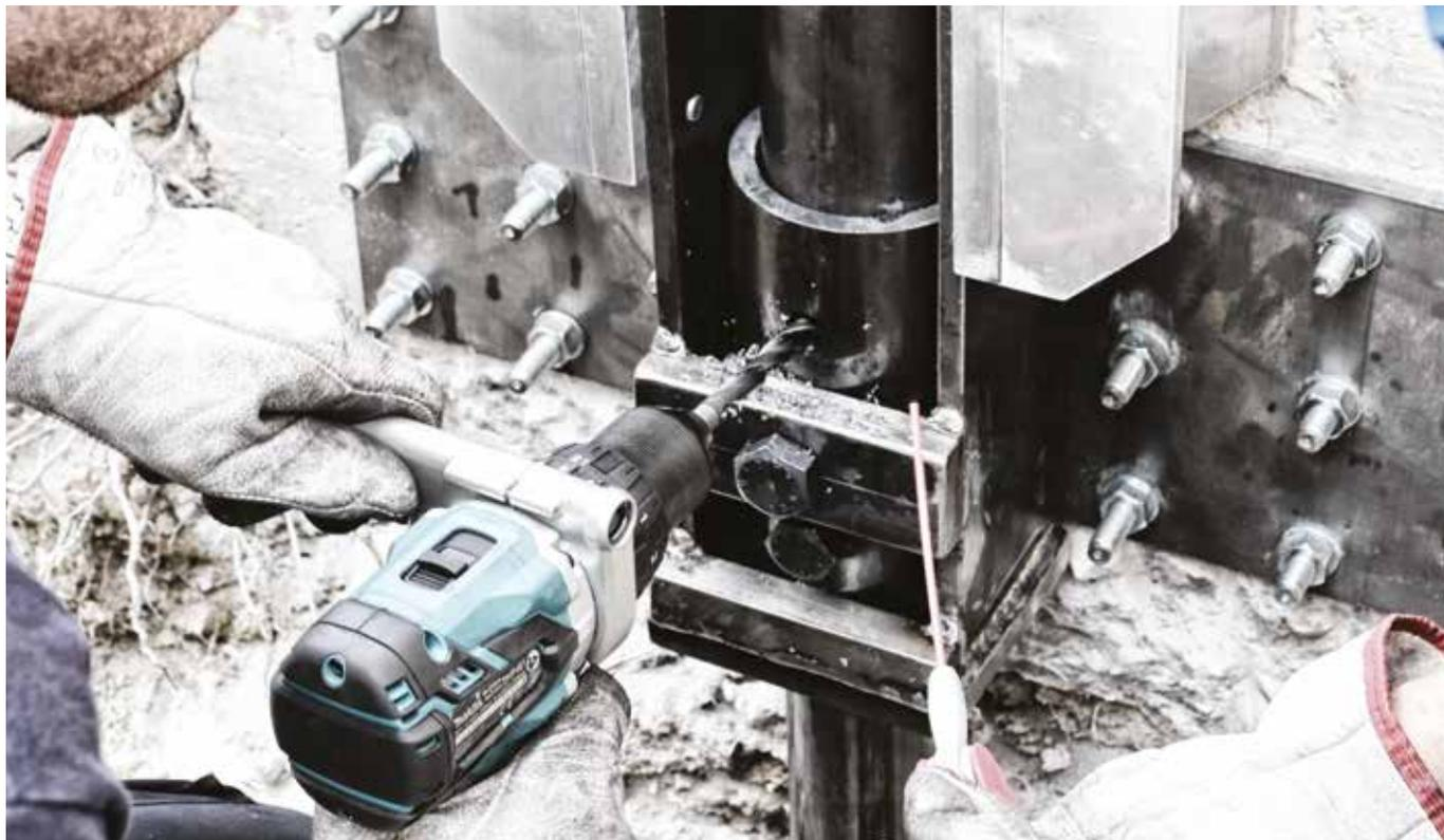
Raggiunta la profondità di progetto o la pressione di rifiuto, si potranno applicare anche carichi superiori a quelli di esercizio con conseguente inibizione del cedimento primario post collegamento. A seguire il palo verrà reso solidale con la fondazione originaria, grazie al fissaggio mediante piastra di ancoraggio. Infine fissato l'ultimo elemento si procede tagliando la parte di palo che risulterà in eccedenza alla testa.
