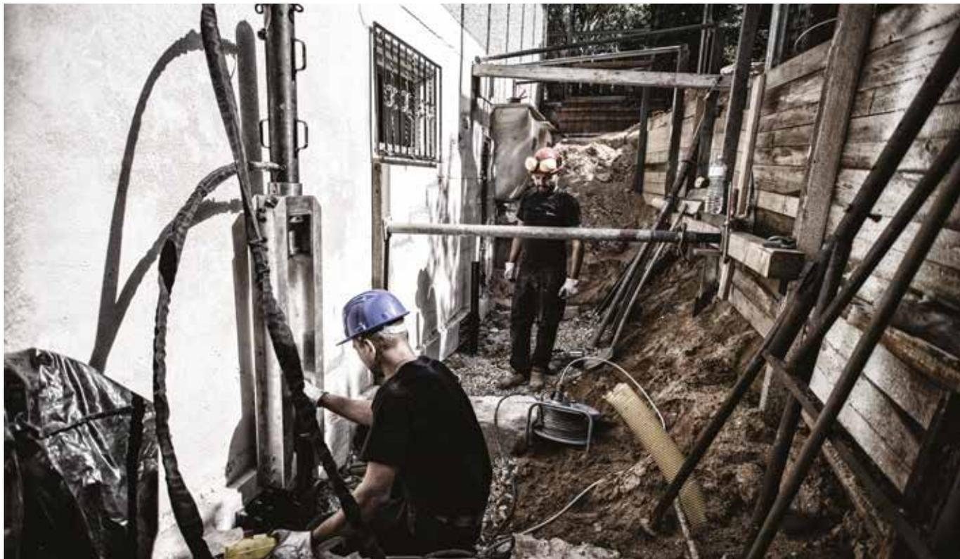
Per l'installazione dei micropali potrebbe essere necessario eseguire degli scavi in prossimità della struttura di fondazione originaria e tali da garantire l'operatività in sicurezza delle nostre maestranze.
