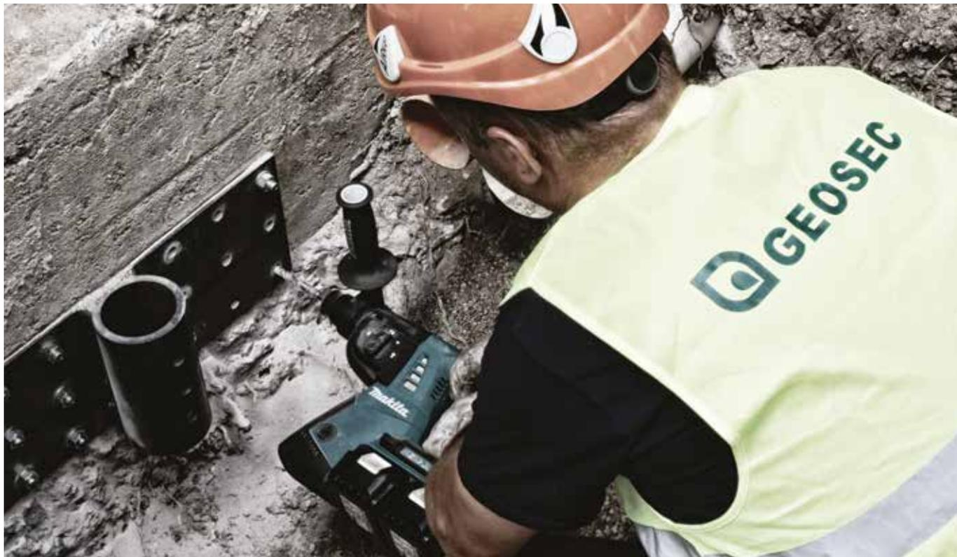
Verificata l'integrità e l'adeguatezza della struttura di fondazione originaria si procede alla posa di piastre d'acciaio opportunamente dimensionate ad accogliere l'aggancio dell'impianto di spinta del palo e a permettere il collegamento micropalo/fondazione esistente.
