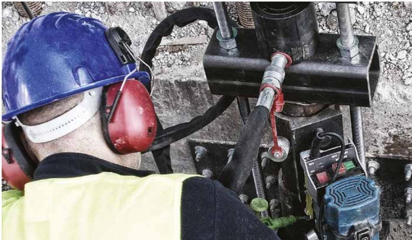
In generale i micropali (diametro < 300 mm) sono correntemente utilizzati in due principali applicazioni: come **elementi strutturali** e **rinforzo dei terreni**. L'impiego come elementi strutturali comprende nuove fondazioni, pali di sottofondazione, miglioramenti statici di vecchie strutture situate in zona sismica ed opere di sostegno dei terreni.
