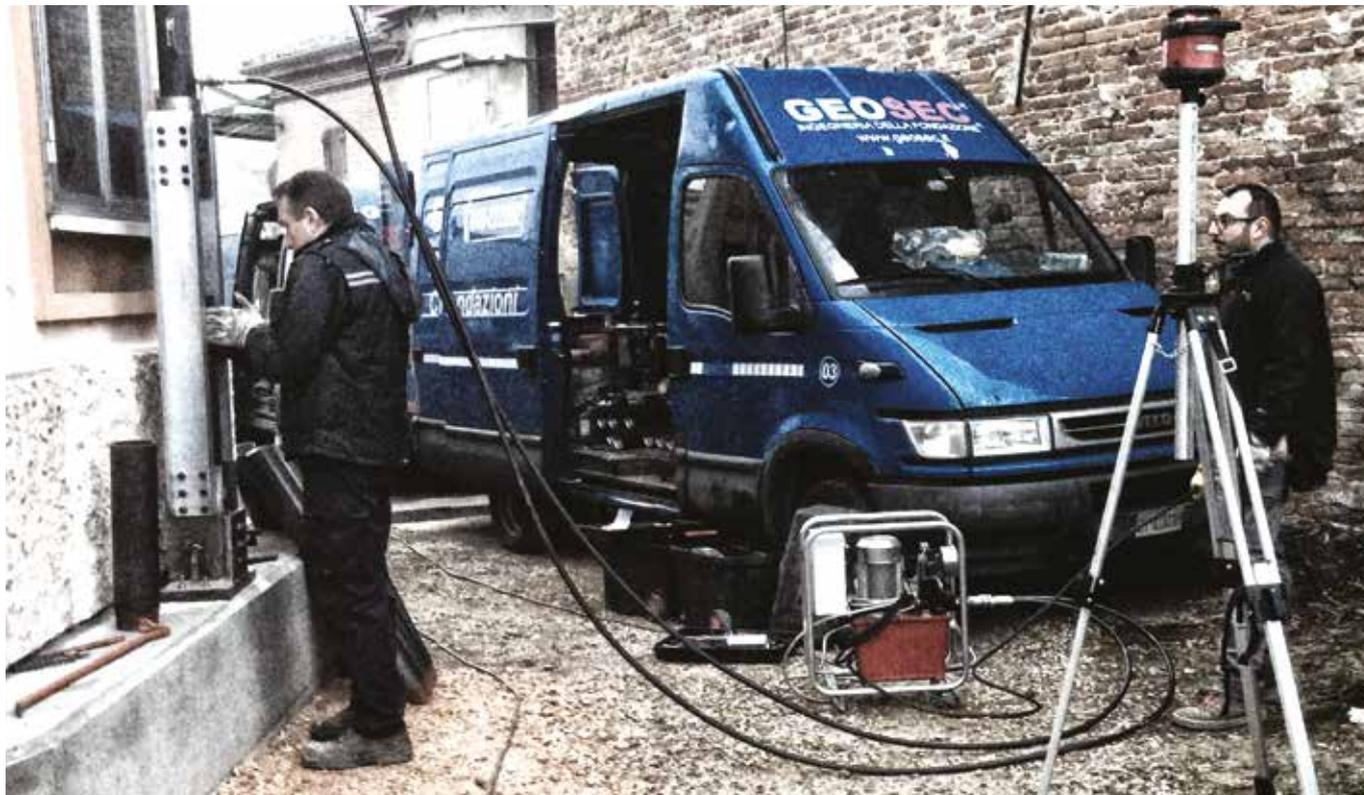
Posizionato il castello di infissione, si procede con l'inserimento di elementi modulari sequenziali, che andranno a costituire il palo di fondazione.
