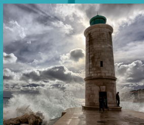
STRUTTURE ESPOSTE AI SALI
