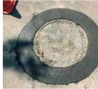
Classe M55 - Carrabile dopo 4 ore
