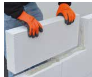
Posa di blocchi GASEBETON®
