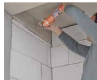
Sigillatura giunti sottili verticali/orizzont.
