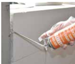
Sigillatura giunti sottili verticali/orizzont.
