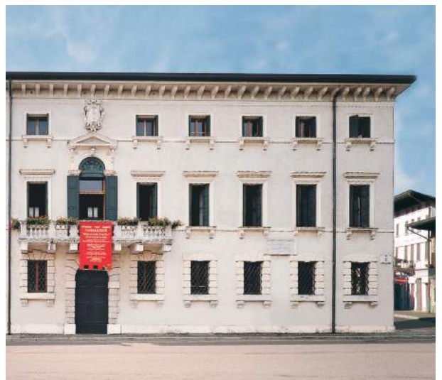
Comune di Sommacampagna (VR): Palazzo Terzi. Intervento di deumidificazione effettuato nel 1985. Barriera idrofobizzante: DryKit System. Formulato: TRE 128 + TRF 135 nelle superfici affrescate
