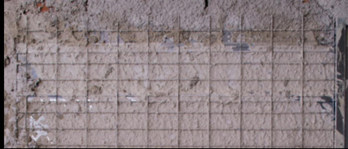
O caixilho é uma estrutura metálica em placa que substitui totalmente uma parte da parede.
