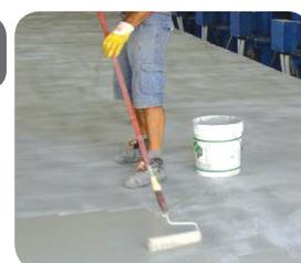
La resa del ciclo applicativo è indicativa e varia in funzione del tipo di supporto e delle condizioni ambientali. I valori specificati sono calcolati a una temperatura compresa tra +15 e +25°C, umidità relativa del 50% circa su supporto compatto e adeguatamente preparato.
