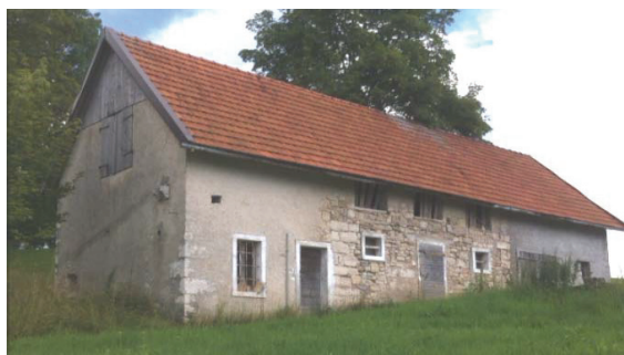
Figura 5.19 - Stato di fatto
