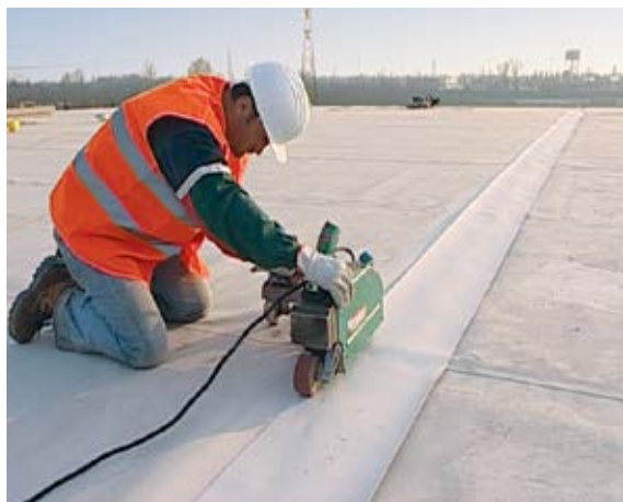
Saldatura giunti/Overlap Welding
