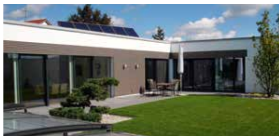
Architetti: HOEWI-Architekten GmbH | Landshut
