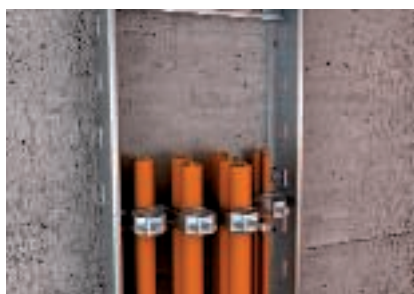
Fissaggio dei cavi singoli o multipli con staffe reggicavo
