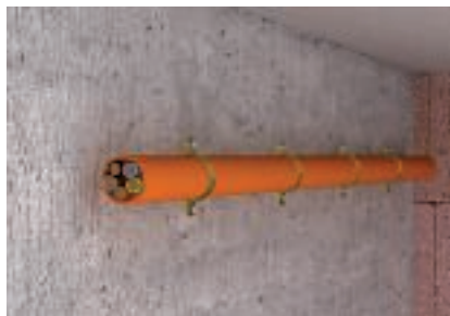
Montaggio orizzontale dei cavi sulla parete
