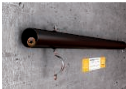
Inserimento nel collare distanziatore tramite l'aggancio della parte superiore sotto la vite
