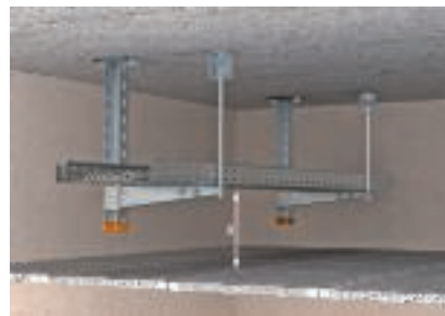
Distanza minima necessaria dal soffitto antincendio
