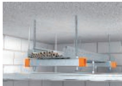
Distanza minima necessaria dal soffitto antincendio
