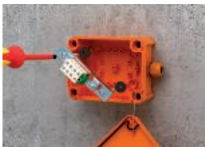
Installazione piastra in acciaio con tassello antincendio direttamente sulla parete
