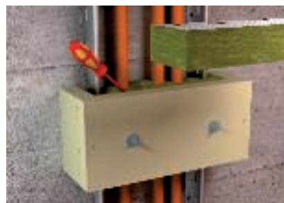
Riempimento con lana minerale adattabile agli spazi in base ai cavi installati
