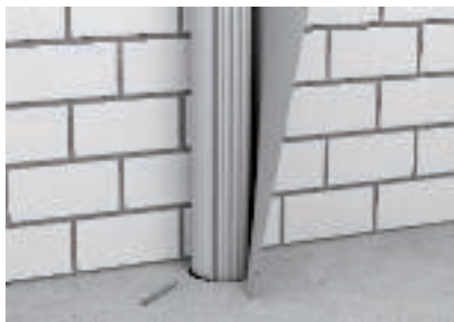
Installazione della fascia resistente al fuoco
