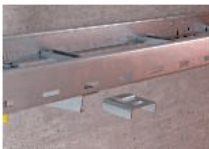
Inserimento del componente di collegamento sulla cinghia di fondo del longherone scala
