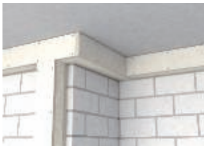
Percorso cavi flessibile tramite pezzi speciali realizzabili sul posto
