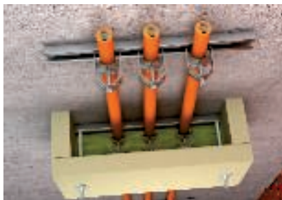
Installazione della compartimentazione locale come protezione antincendio dei fissaggi dei cavi con profilato
