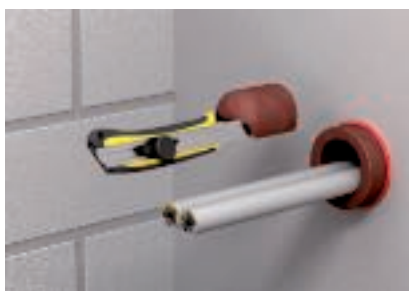
Tagliare e inserire il tappo nel rivestimento
