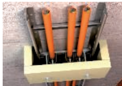
Installazione della compartimentazione locale come protezione antincendio dei fissaggi dei cavi con passerella a traversini
