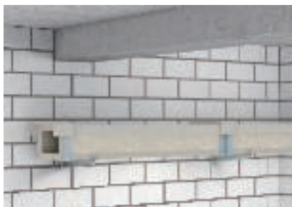
Installazione a parete come canale classe I (DIN 4102-11)
