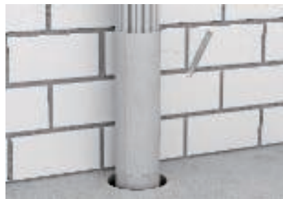
Fissaggio della fasciatura tramite filo di avvolgimento
