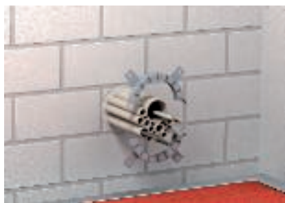
Collegare le metà del collare e fissare alla parete
