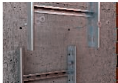
Versione giunti senza connettore avvitato
