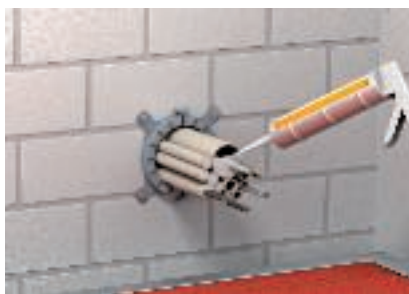
Chiusura delle estremità dei tubi con materiale isolante DSX
