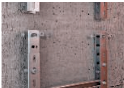
Versione giunti con connettore avvitato
